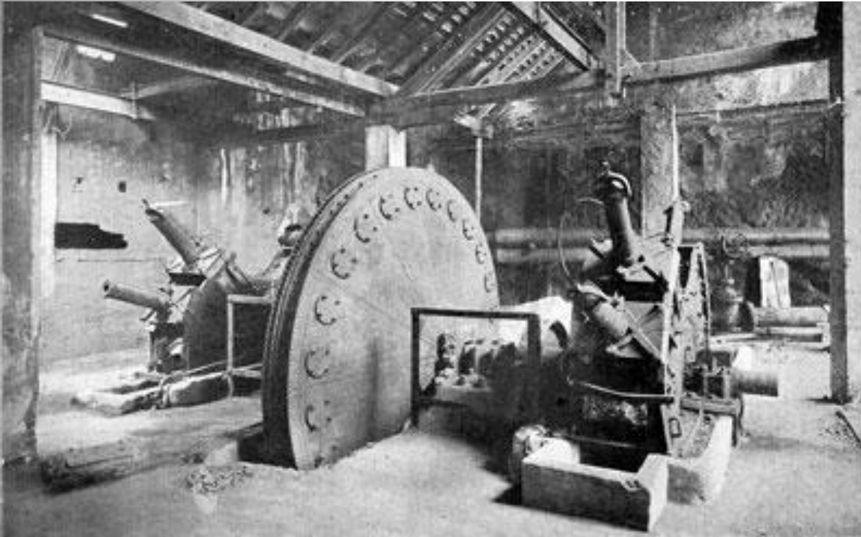
1872 : Entraînement par turbines des défibreurs aux papeterie de Lancey (Isère)
